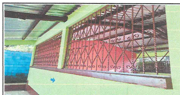
Foto 12. Pintura exterior de las aulas concluido.
