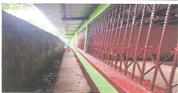
Foto 5: Pintura de balcones concluido
