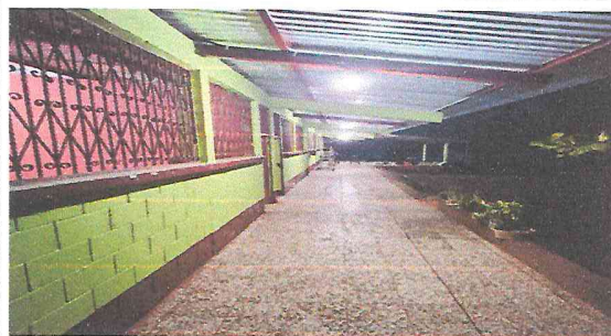
Foto 2: Pintura en todo el centro educativo concluido.
