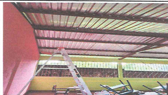
Foto 4: Sustitución de lámina por lámina troquelada concluido.
