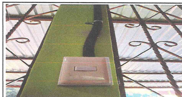
Foto 10. Instalación de timbre concluido.
