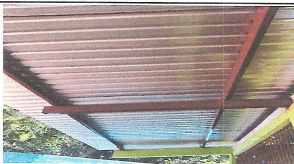
Foto 3: Sustitución de estructura metálica concluido.
