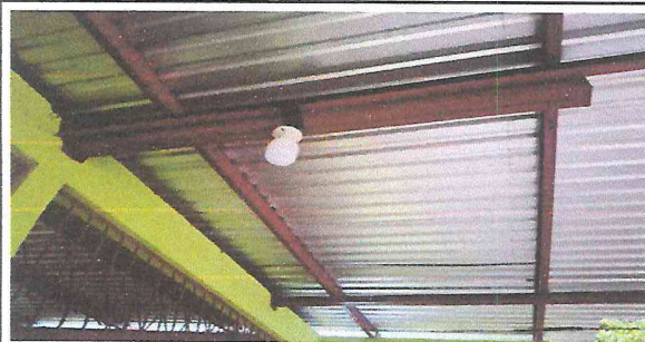
Foto 1: Sustitución de lámpara por fotos concluido
