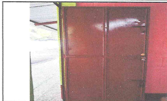
Foto 8. Sustitución de chapas y mantenimiento de puertas concluido.
