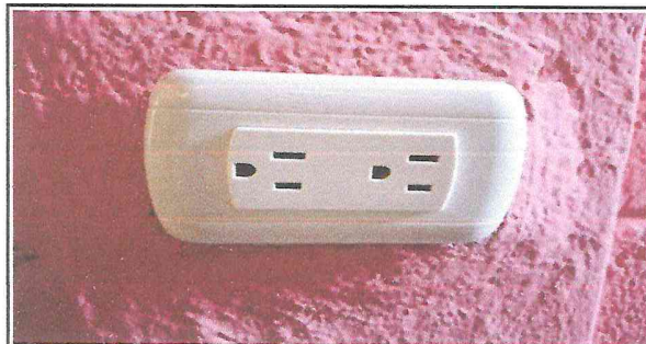
Foto 9. Sustitución de tomacorrientes concluido
