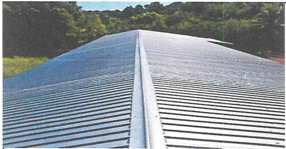
Foto 7. Sustitución de lámina por lamina troquelada concluido.
